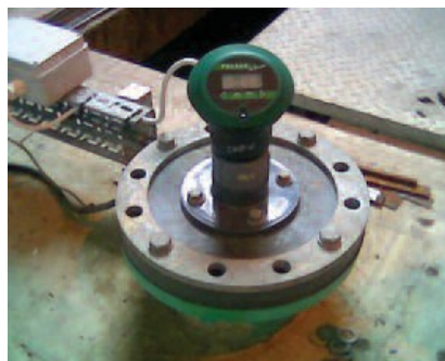
نصب IMP بر روی یک مخزن آهک مایع
