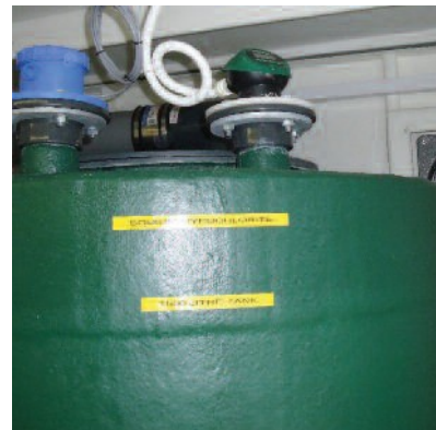
بر روی مخزن مواد IMP نصب سنسور ارتفاع
